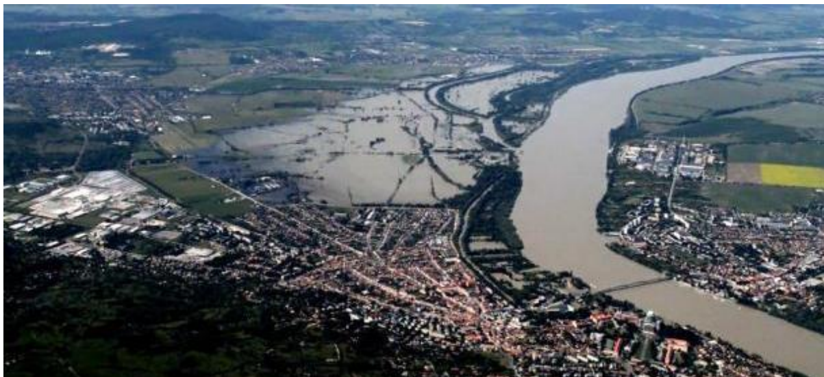
15. fig. Flood damages in 2013 (source: https://www.szeretgom.hu/content/78702-egesen-esztergom-kertvarosig-vezetnek-a-gatat )
