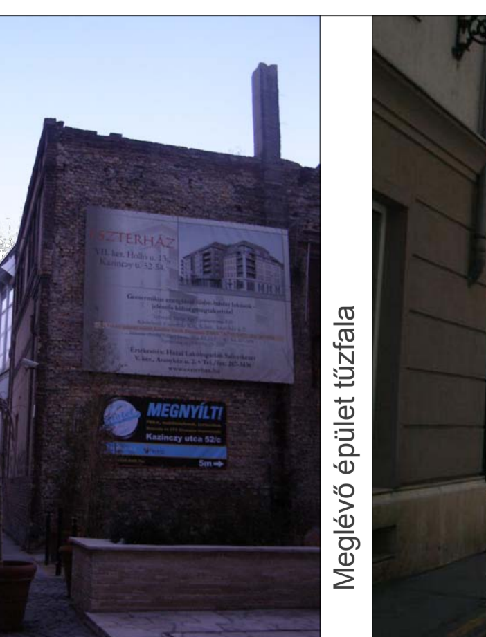
Meglévő épület tűzfala
