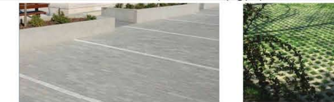
térbukolattal ellátott felület az autós forgalom számára, mely a parkolók vonaláig tart. Az utolsó öt parkoló hely gyepráccsal készül
