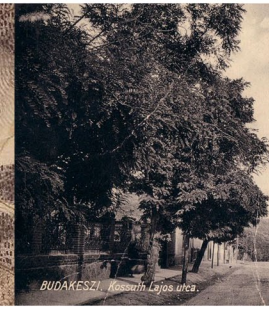
Kossuth Lajos utca_ volt filmszínház épülete (j)
