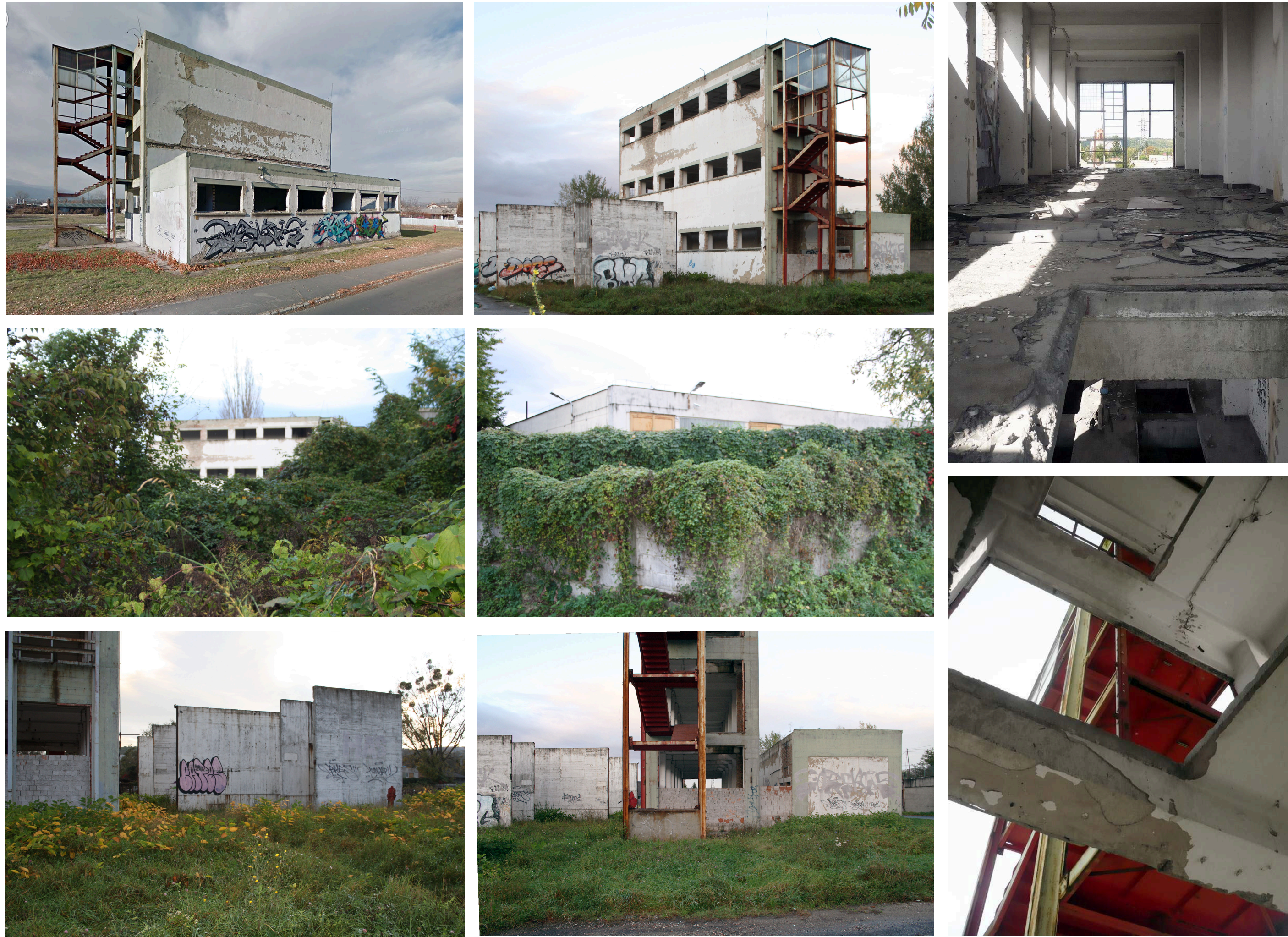
A TALÁLT ÉPÜLET: OXIGÉNYÁRI ALÁLLOMÁS ÉPÍTÉS ÉVE: 1980
