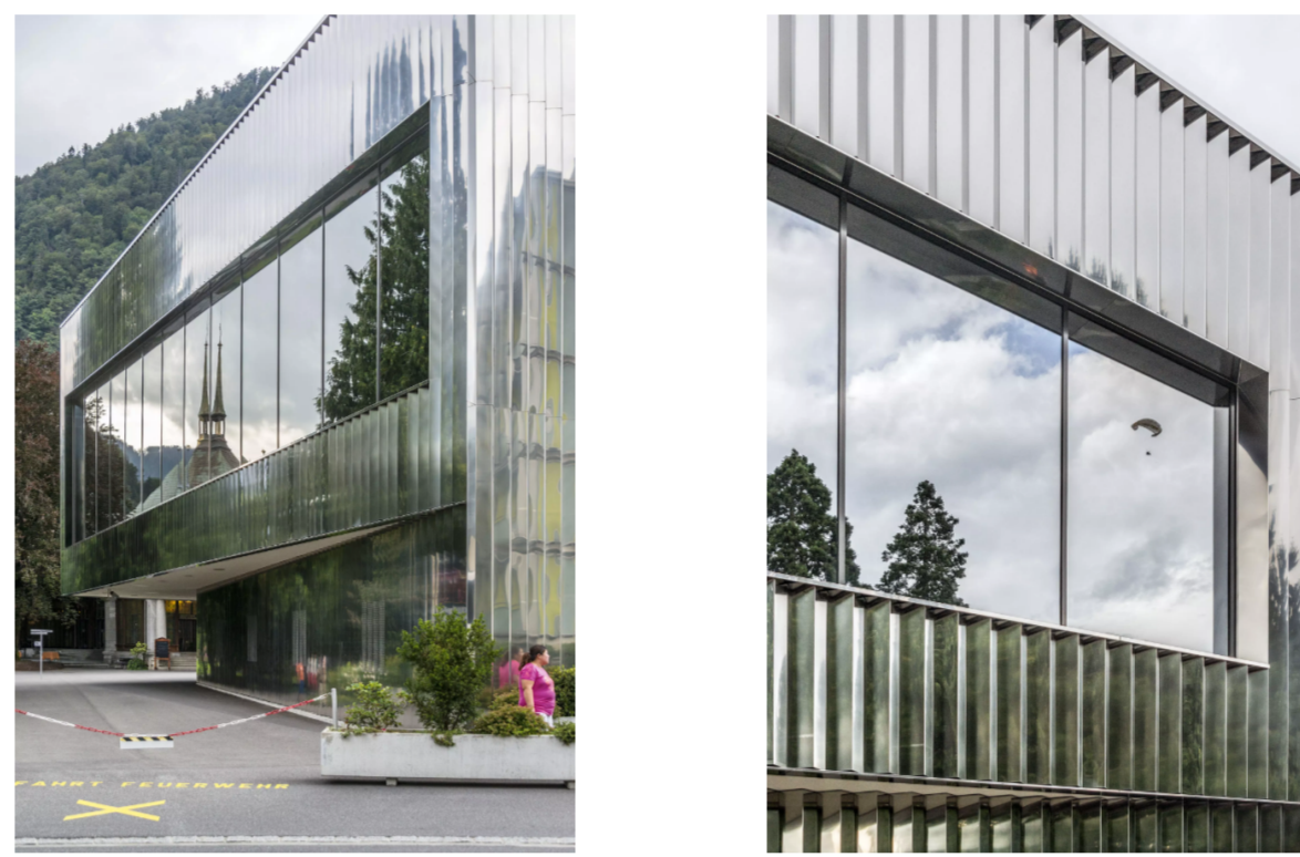
KUNZ UND MÖSCH ARCHITEKTEN, DORENBACH ARCHITEKTEN CONGRESS CENTER KURSAAL INTERLAKEN interlaken, svájc 2010 polírozott alumínium homlokzat burkolat
