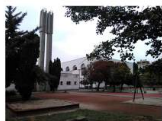
KORSZERŰLEN KAZÁNHAZ, MARKÁNS KÉMÉNY
