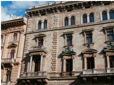
SAXLEHNER- PALOTA ANDRÁSSY ÚTI HOMLOKZATA (ÉPÍP)
