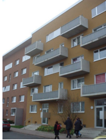
Felújított panelépület - Leinefelde, Németország (Szabó Franciska felvétele)
