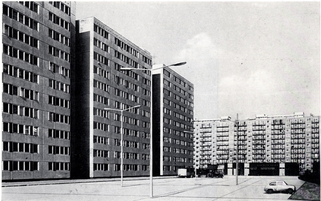
Épületek az Árpád út felől nézve 2 és 3 jelű épületek között. Háttérben a földszintes üzletek, mögöttük a 8 jelű lakóház (1974) Fotó: Vassányi Béla
