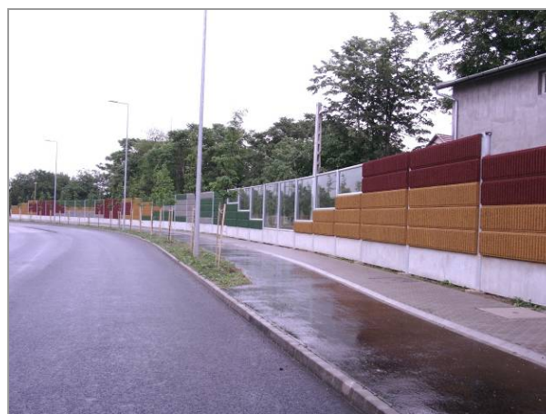
Csepeli gerincút zajvédelme (forrás: BKK Zrt.)
